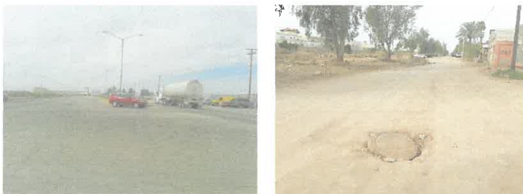
Vialidades pavimentadas y sin pavimentación dentro de la zona de estudio.
