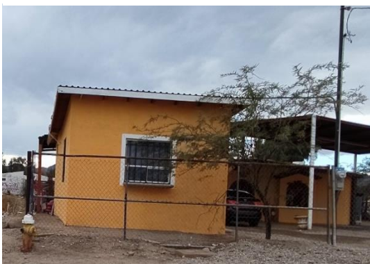
Figura 55: Vivienda en fracc. de tipo popular “Zona Progreso”.
