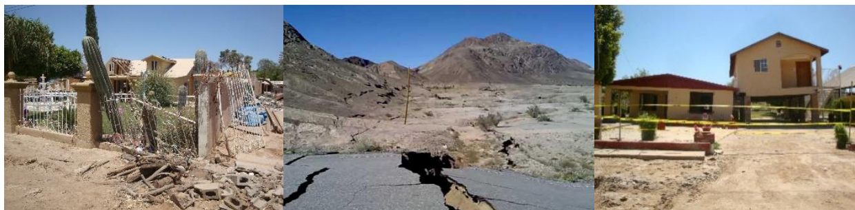
Figura 42: Daños provocados por el sismo de 7.2 grados en Mexicali en el 2010.
