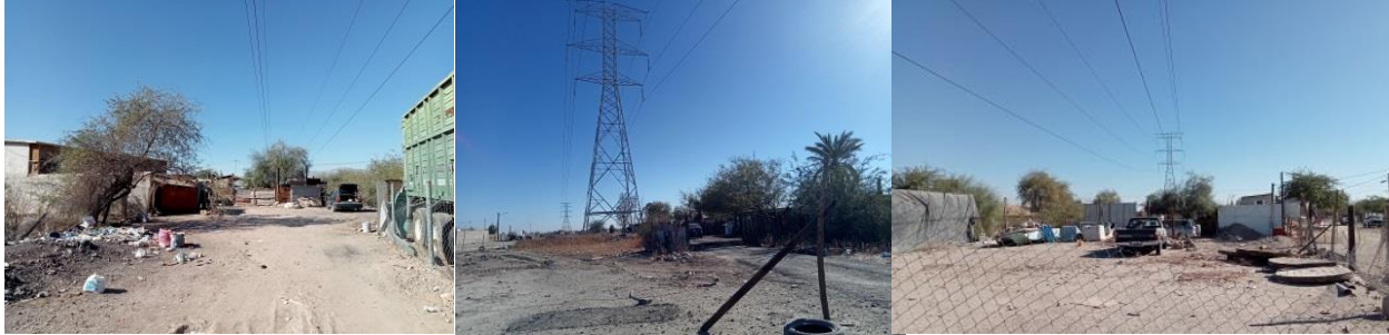
Figura 38: Invasión de derechos de vía de la CFE.
