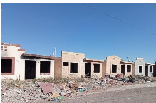
Figura 58: Vivienda abandonada en Villas de Alarcón.
