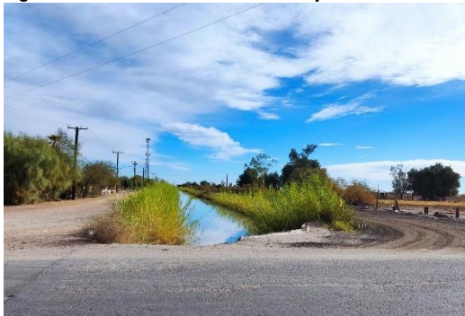
Figura 147: Canal lateral 95+224 izq. del Reforma
