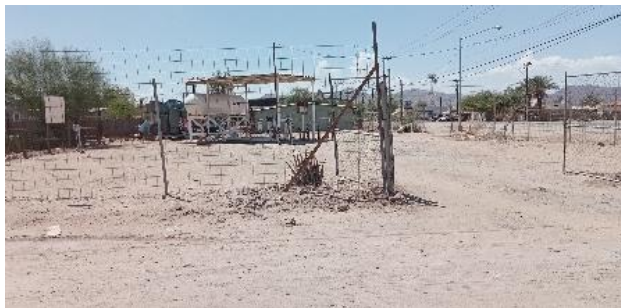
Figura 37: Estación de carburación en el AE (1).
