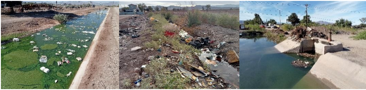
Figura 30: Contaminación de drenes y canales en el AE.
