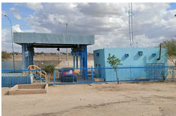
Figura 105: PBAR No. 9 Progreso operada por la CESPM.
