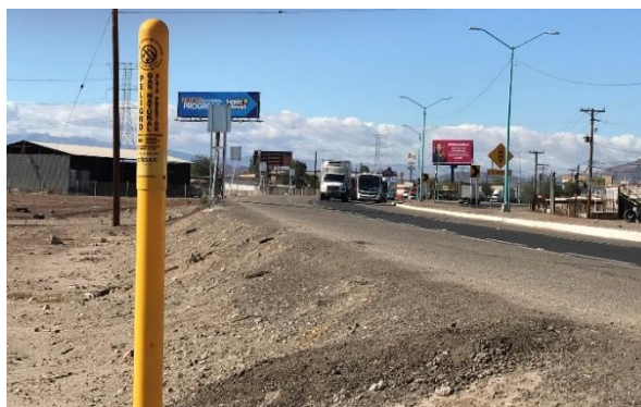
Figura 113: Señalización del paso del gasoducto de 8 pulgadas de diámetro operado por ECOGAS en cuerpo sur de Carr. a Tijuana.
