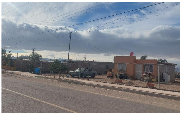
Figura 91: Banquetas parciales de acceso a la zona escolar en la c. Venustiano Carranza.
