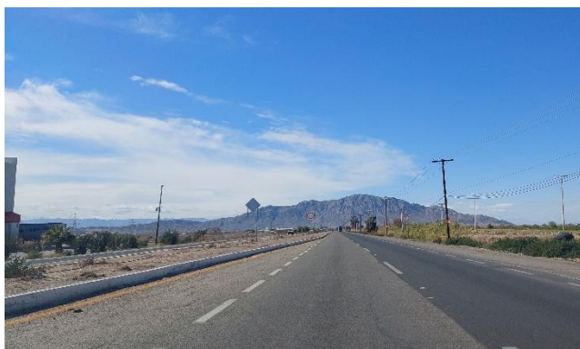
Figura 68: Carr. Mexicali-Tijuana vista al poniente, velocidad de 80km/h.
