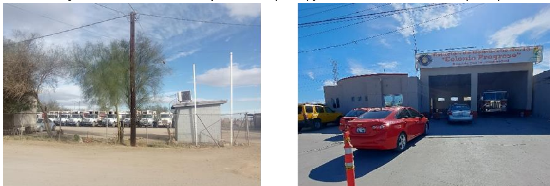
Figura 123: Coordinación de limpia Poniente (AP-01) y Estación de bomberos No. 13 (SU-01)
