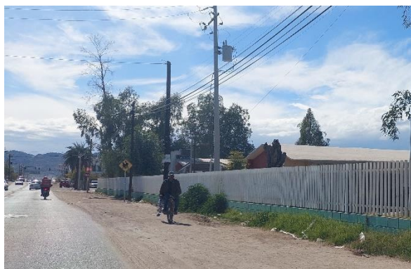
Figura 95: Falta de infraestructura ciclista, rodamiento sobre vía principal en la carr. Progreso-Santa Isabel.
