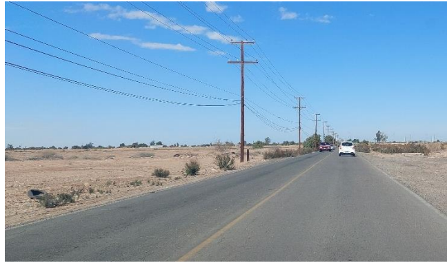
Figura 69: Tramo existente del circuito exterior, en la carr. Progreso-Mexicali.
