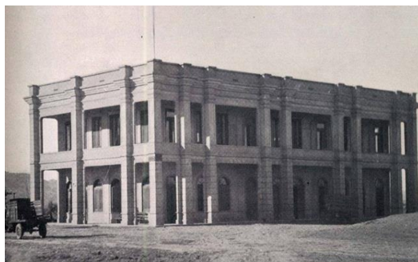
Figura 43: Edificio histórico “Casa de la Cultura de la Colonia Progreso”
