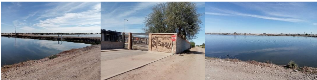
Figura 29: Planta de Tratamiento de Aguas Residuales (PTAR) en los límites del AE.
