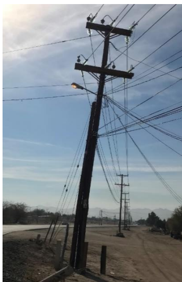
Figura 112: Poste de luz con alumbrado público en regulares condiciones.
