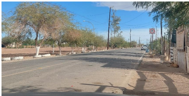
Figura 75: Av. Hidalgo, vista al oeste.
