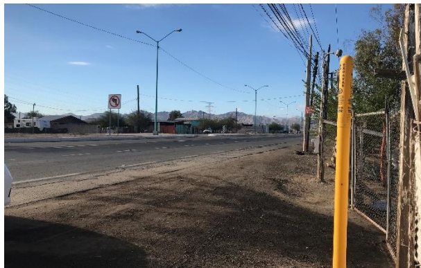
Figura 116: Señalización del paso de la fibra óptica en cuerpo norte de la Carr. a Tijuana.
