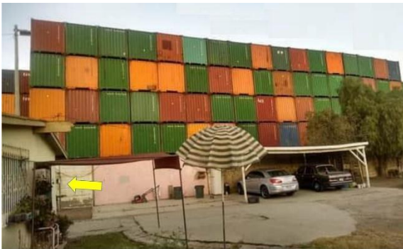
FIGURA 47 ALMACENAMIENTO DE CONTENEDORES JUNTO A CASA - HABITACIÓN
