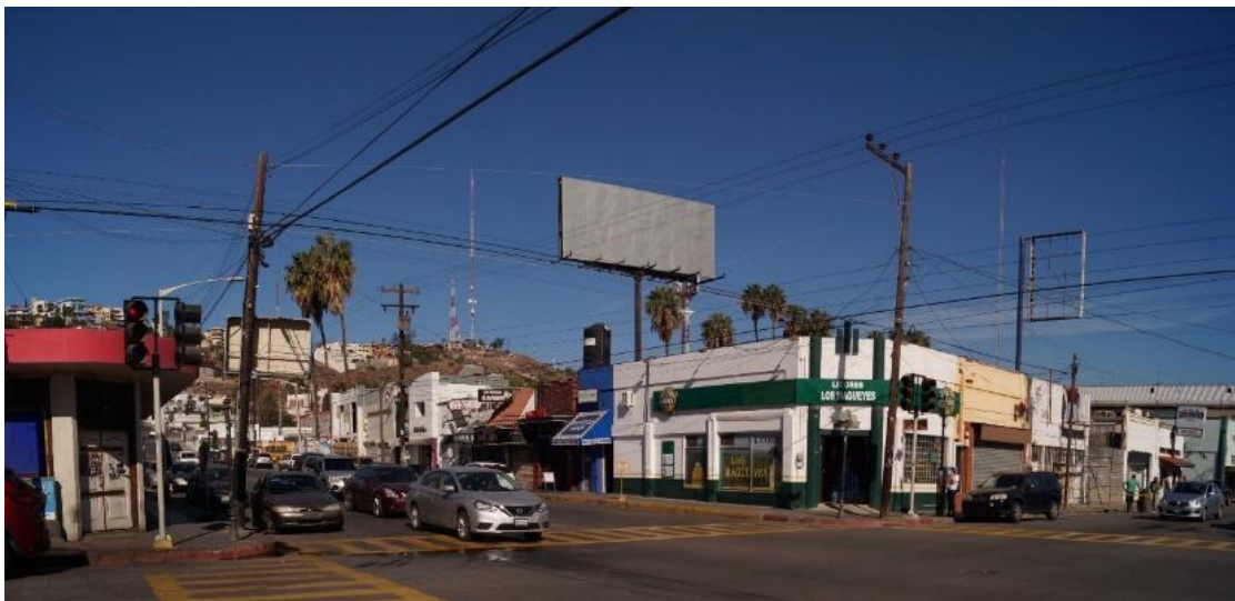
FIGURA 73 PAISAJE URBANO DETERIORADO POR ANUNCIOS, POSTES Y CABLEADO AÉREO
