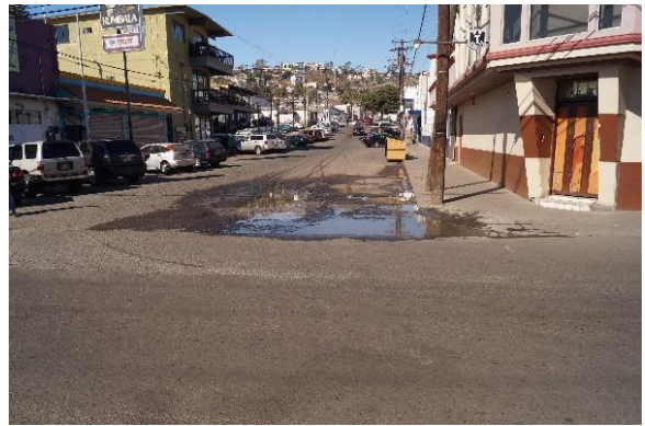
FIGURA 53 PAVIMENTOS IMPERMEABLES SIN PREVISIÓN PARA EL MANEJO DE LOS ESCURRIMIENTOS PLUVIALES
