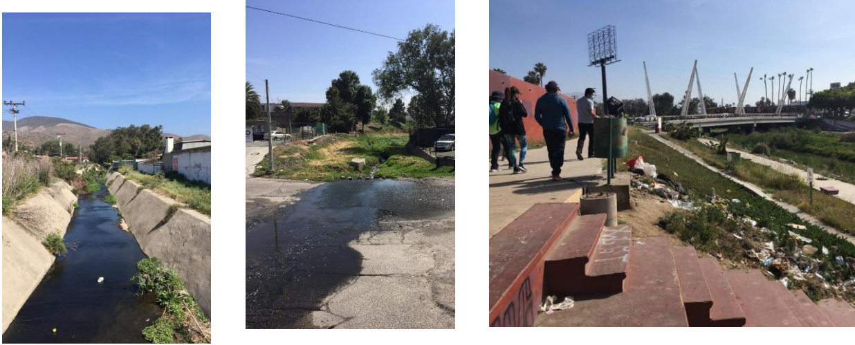
Figura 25 AGUAS RESIDUALES SEMI-TRATADAS Y BASURA A LO LARGO DE LOS ARROYOS
