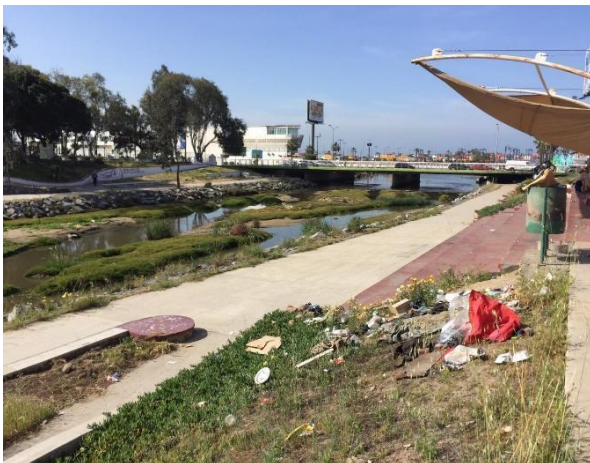
FIGURA 23 ESCURRIMIENTO DE AGUAS RESIDUALES Y BASURA EN ARROYOS
