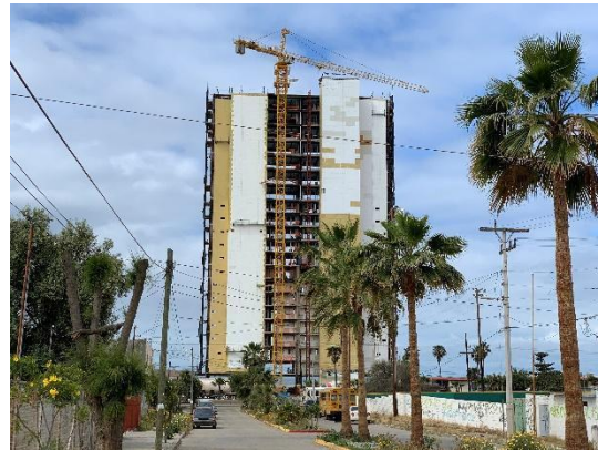
FIGURA 75 CONSTRUCCIONES MASIVAS QUE NO SE INCORPORAN AL PAISAJE Y QUE DEMERITAN EL VALOR DE LOS PREDIOS EN LAS ZONAS PREVIAMENTE ESTABLECIDAS
