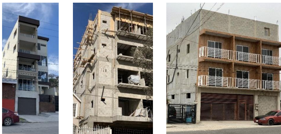
FIGURA 83 EDIFICACIONES CON EVIDENTE INCUMPLIMIENTO EN EL PORCENTAJE DE OCUPACIÓN DEL PREDIO, INVASIÓN A LA VÍA PÚBLICA Y VENTANAS EN COLINDANCIA
