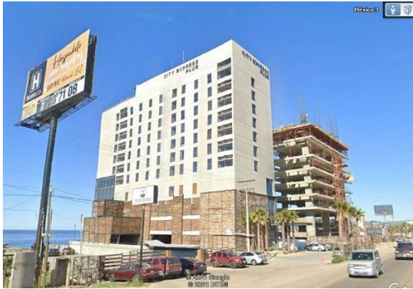
FIGURA 74 EDIFICACIONES Y ESPECTACULARES QUE OBSTRUYEN LA VISTA DESDE LA CARRETERA ESCÉNICA HACIA EL MAR, CON LO QUE SE REDUCE EL VALOR PAISAJÍSTICO DE LA CIUDAD
