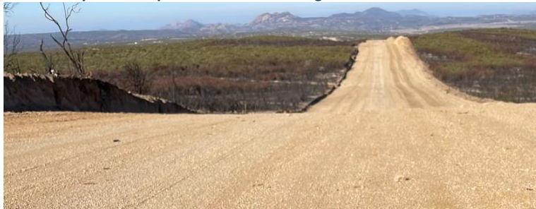
Ilustración 21. Trazo liberado y nivelado para la instalación del gasoducto dentro de los límites del área de estudio
