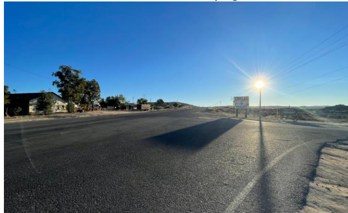
Fuente: elaboración propia, inspección con fecha del 03 de noviembre de 2023.
