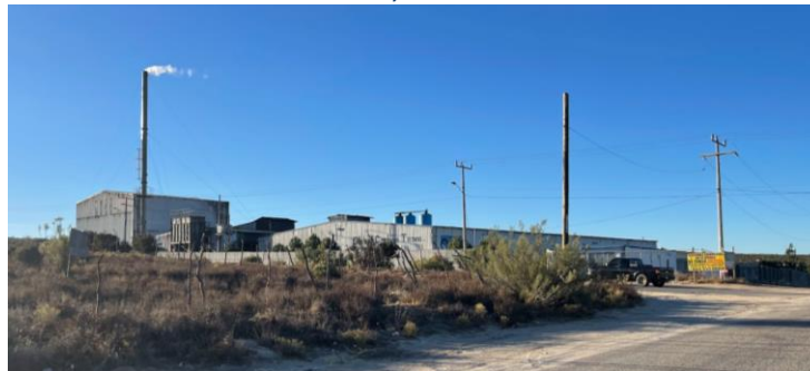
Fuente: elaboración propia, inspección con fecha del 03 de noviembre de 2023.
