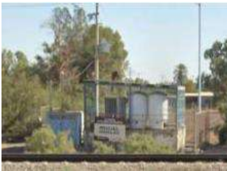
Figura 38. Planta potabilizadora de agua “Miguel Hidalgo”.
