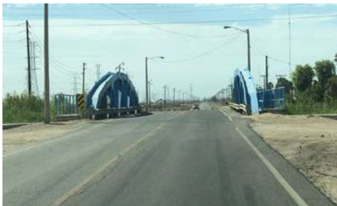
Figura 66. Puente vehicular sobre Dren, Sección 1.
