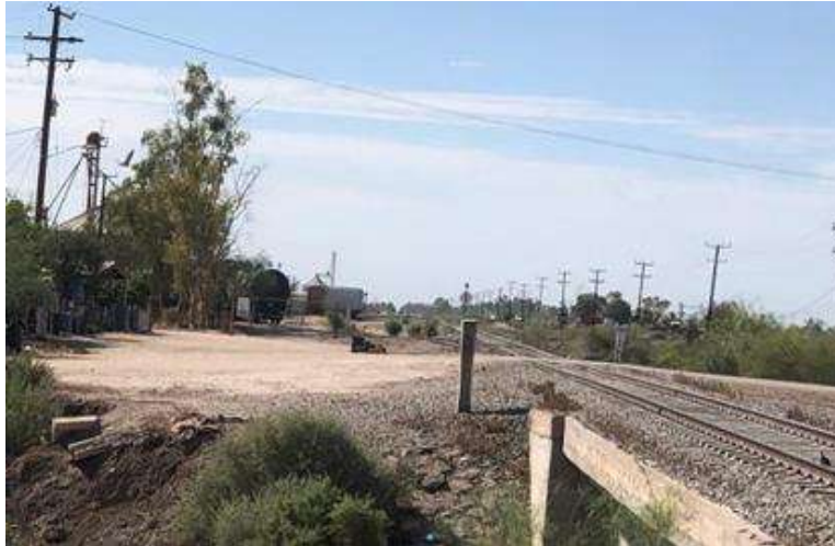
Figura 64. Cruce de caminos de terracería con vías de ferrocarril, Sección 1.
