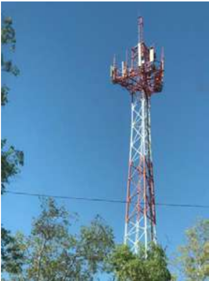
Figura 45. Antena de comunicación, ejido Michoacán de Ocampo.
