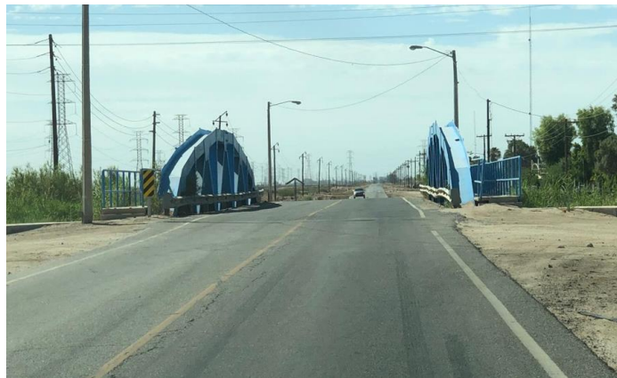
Figura 66. Puente vehicular sobre Dren, Sección 1.
