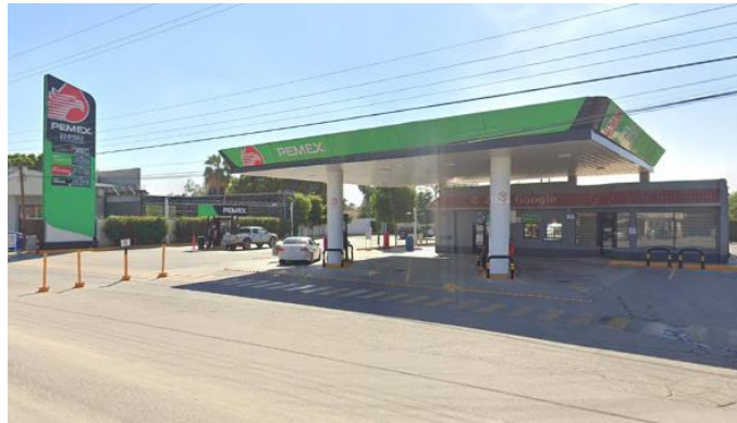
Figura 60. Gasolinera Colonia Nuevo León.
