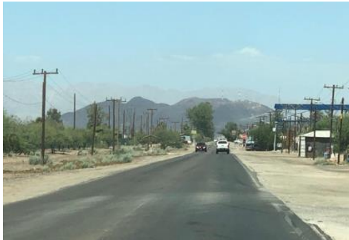
Figura 71. Carretera Estatal #2 Mexicali-Algodones, vista al oeste.
