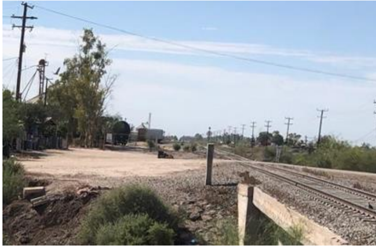
Figura 64. Cruce de caminos de terracería con vías de ferrocarril, Sección 1.
