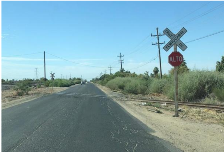
Figura 65. Cruce carretera estatal #2 con vías del ferrocarril.
