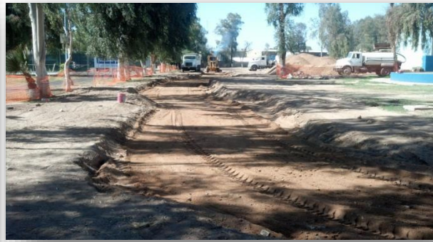
COLOCACION DE TUCURUGUAY
