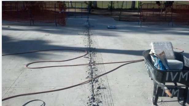
CORTE CON DISCO PARA COLOCACION DE GUIA
