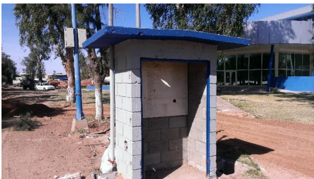
MURETE PARA DEMOLER
