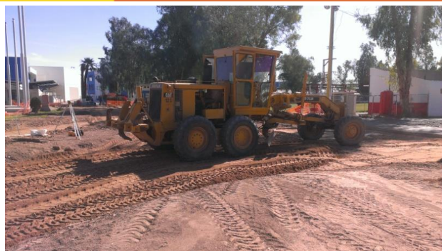
COLOCACION DE TUCURUGUAY
