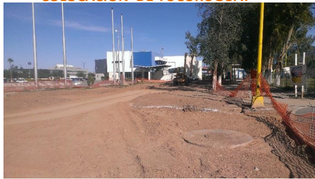
COLOCACION DE TUCURUGUAY
