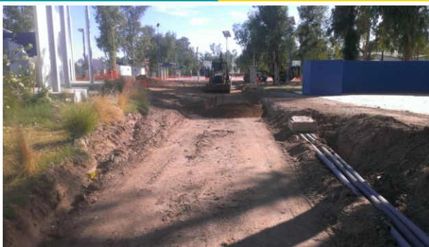
COLOCACION DE TUCURUGUAY
