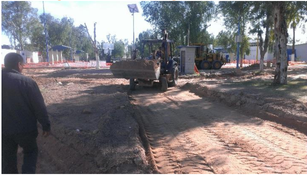
COLOCACION DE TUCURUGUAY
