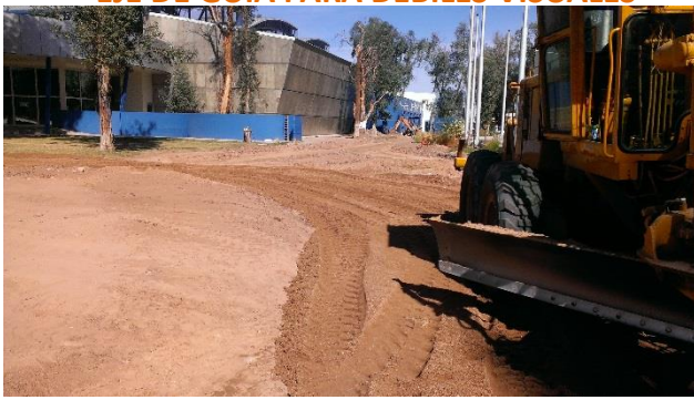
COLOCACION DE TUCURUGUAY
