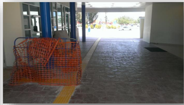
COLOCACION DE GUIA EN AREA DE OFICINAS
