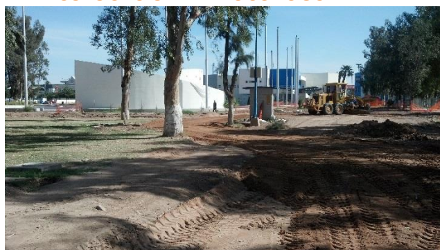
COLOCACION DE TUCURUGUAY
