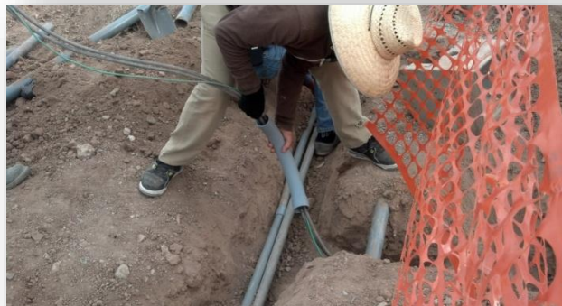
REUBICACION LINEAS ELECTRICAS
