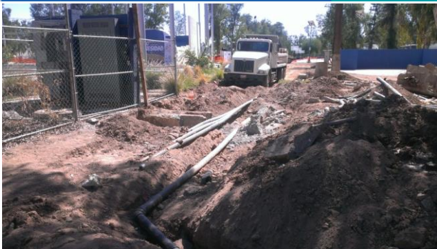
REUBICACION LINEAS ELECTRICAS
