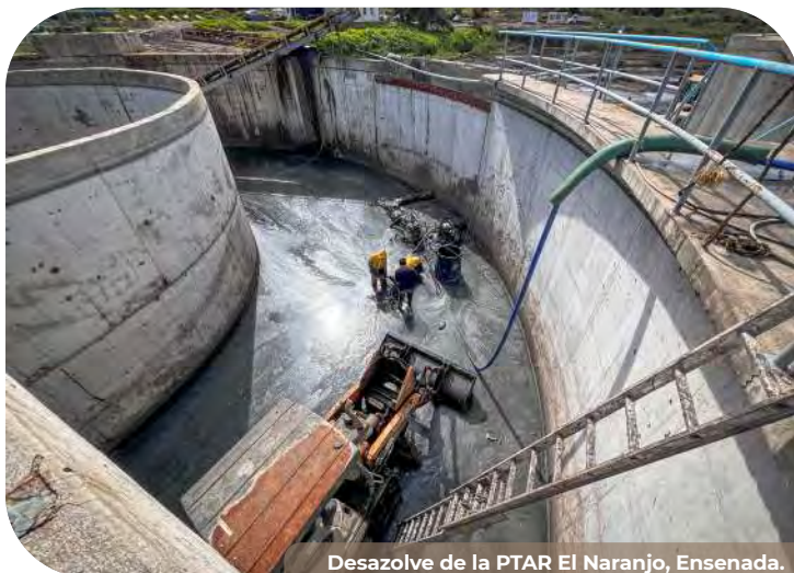
Desazolve de la PTAR El Naranjo, Ensenada.
